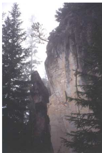
Fig. 55 - Distacco di una scaglia decametrica da una bancata di marmi
