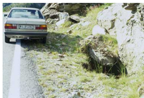
Fig. 43 - Trincea a monte della strada statale del Passo Gavia.
