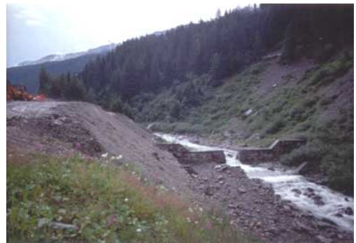
Fig. 59 - Briglie sul Torrente Frodolfo. Una è quasi completamente annegata nei depositi.
