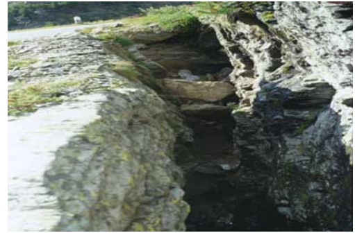
Fig. 44 - Trincea a monte della strada statale del Passo Gavia.
